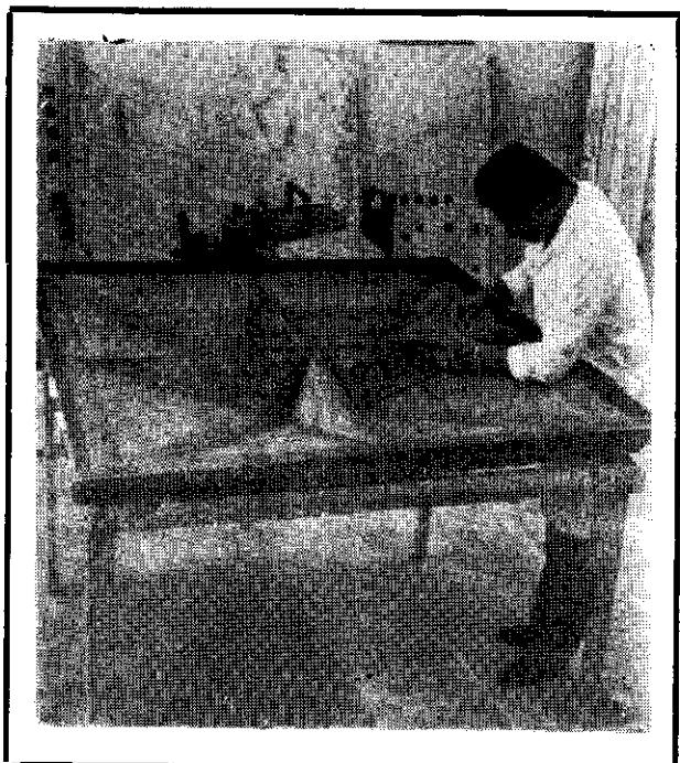
F16 - Fôrma da estrutura em cascas poliédricas, em fase de colocação da armadura.
