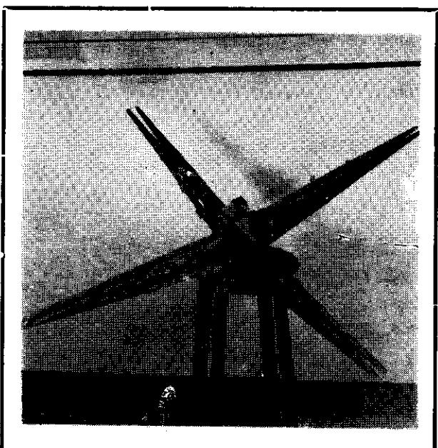
F3 - Fôrma das vigas centrais de enrijecimento e da parte superior do pilar.
