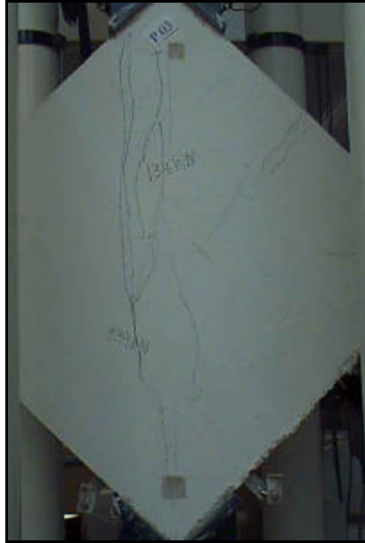
Figura 6.4 – Fissuras na parede P03.
