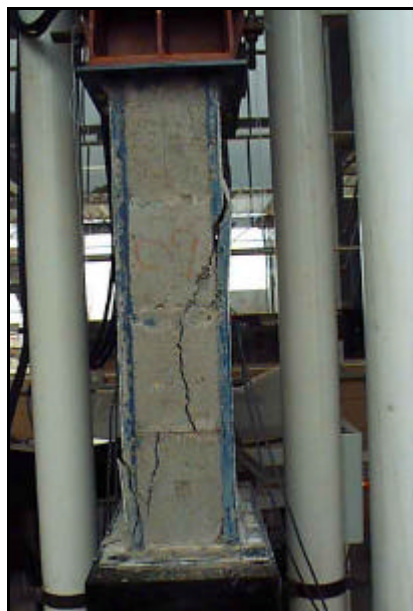
Figura 5.10 - Ruptura dos septos dos blocos parede P07.
