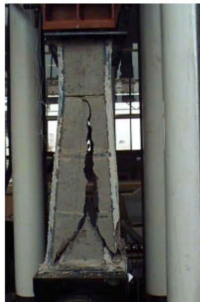
Figura 5.5 - Ruptura dos septos os blocos.
