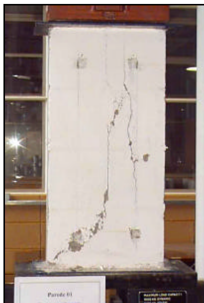
Figura 5.1 - Ruptura da parede P01.
