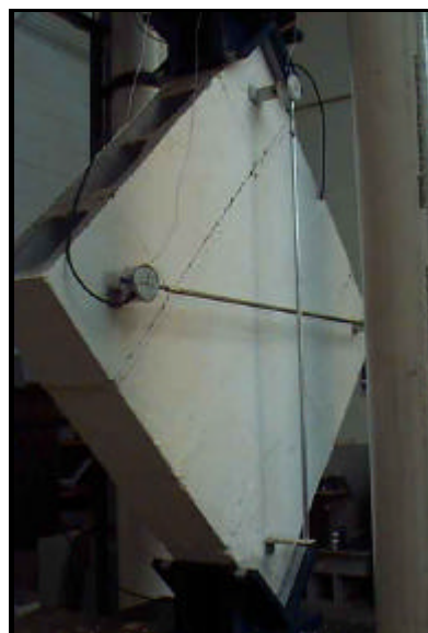
Figura 4.25 - Ruptura na interface tijolo-argamassa.
