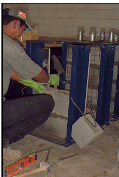
Figura 4.12 - Execução das paredes com o gabarito.
