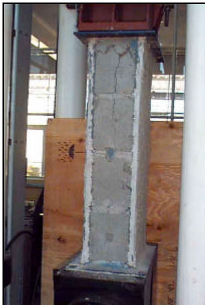
Figura 5.17 - Fissura nos septos dos blocos da parede P11.
