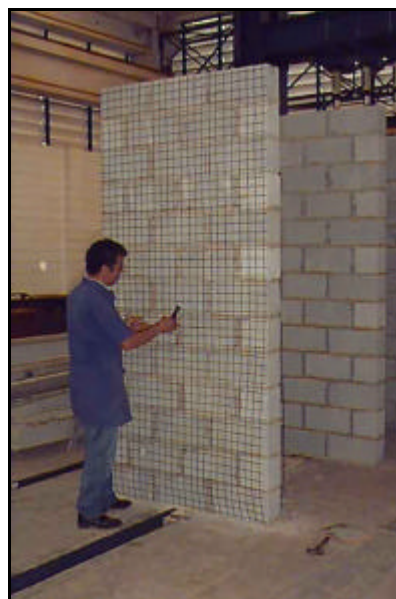
Figura 4.6 - Colocação das telas.
