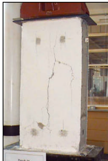
Figura 5.8 - Ruptura da parede P06.
