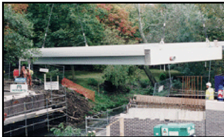
Figura 4.5 : Ponte West Mill em Oxford, Reino Unido.
