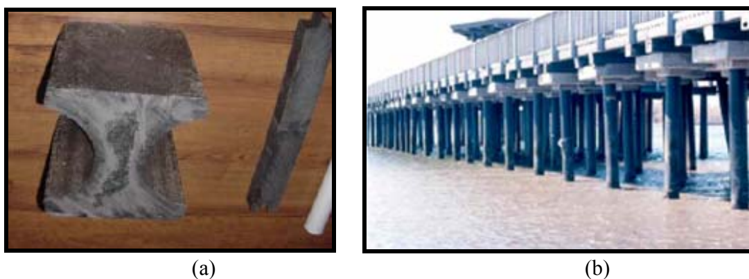
Figura 1.4: Marina construída com pilares de plástico reciclado desenvolvido na AMIPP.
