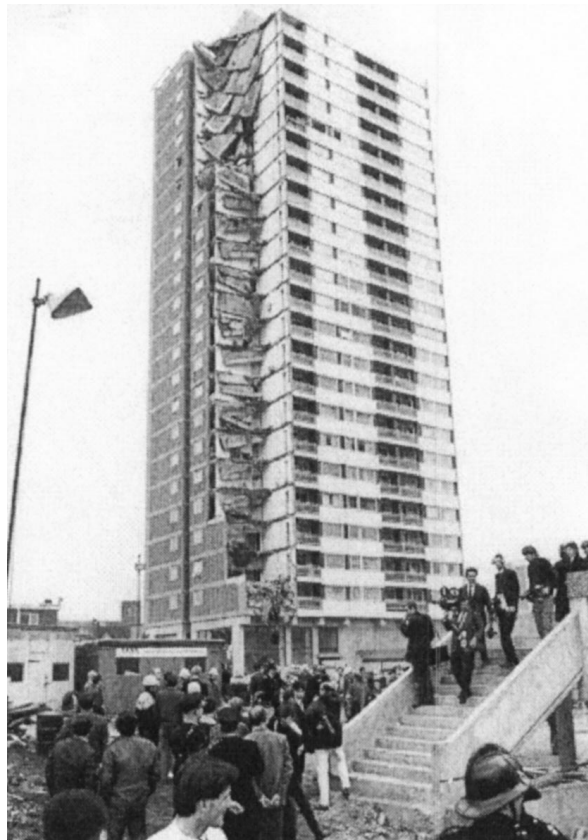
Figura 1 – Edifício Ronan Point após o colapso.
