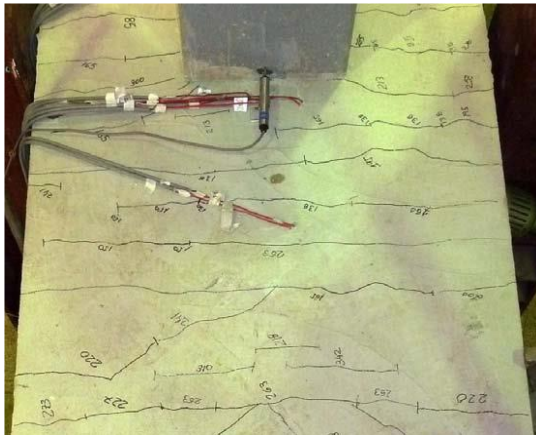
a) Fissuração na capa de concreto do modelo experimental.
