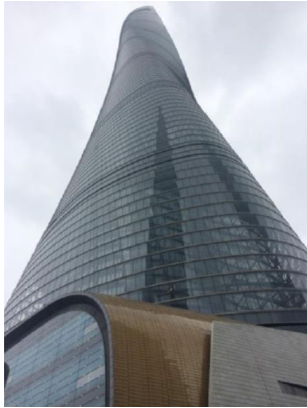
Figura 1-1 - Torre de Xangai - China.
